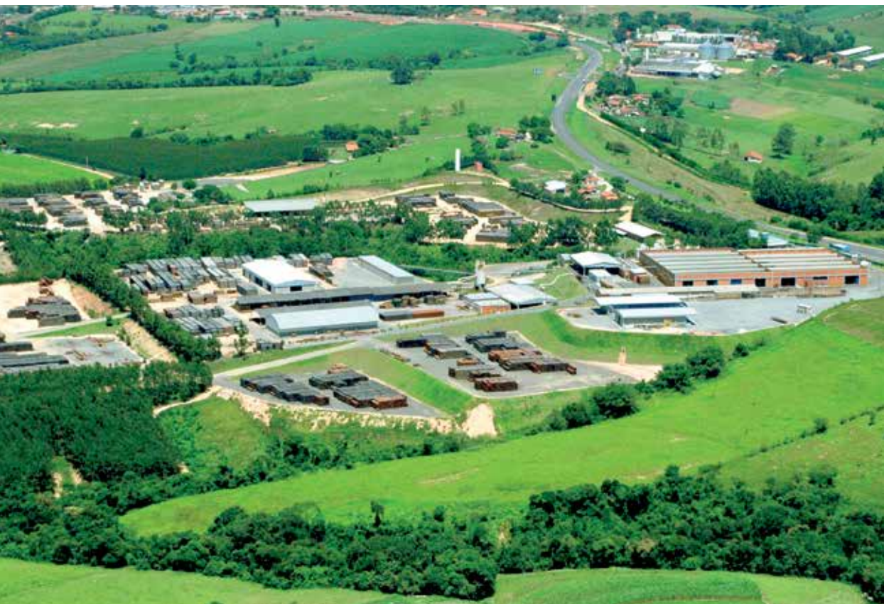
FÁBRICA 1 / FACTORY 1 / FABRICA 1 - TIETÊ
