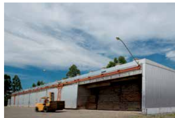
FÁBRICA 1 / FACTORY 1 / FABRICA 1 - TIETÊ
